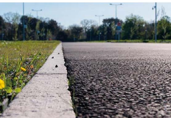
Carbon Light est une gamme innovante d'enrobés bitumineux présentant de belles performances environnementales grâce à l'utilisation d'un liant d'apport neutre en carbone intégrant un additif biosourcé. Carbon Light est fabriqué à température abaissée.
