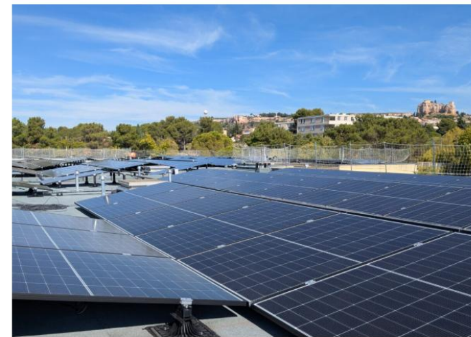
Solarisation du groupe scolaire Martine Morin.
